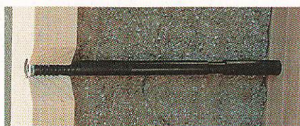
Horizontale Verschraubung durch Tragwerk, Isolation und Montageteil.
